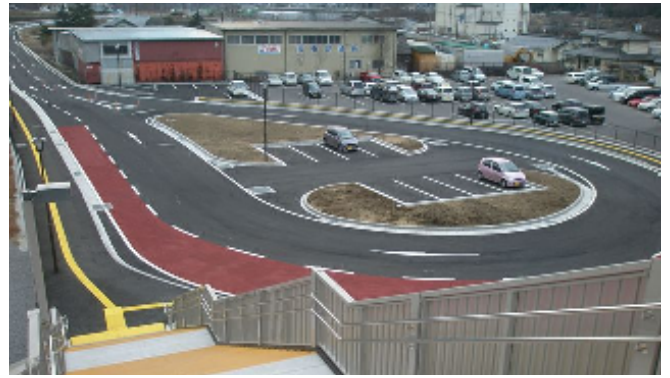
利用者も少なくガラとした田中駅南口（連絡橋から撮影）
